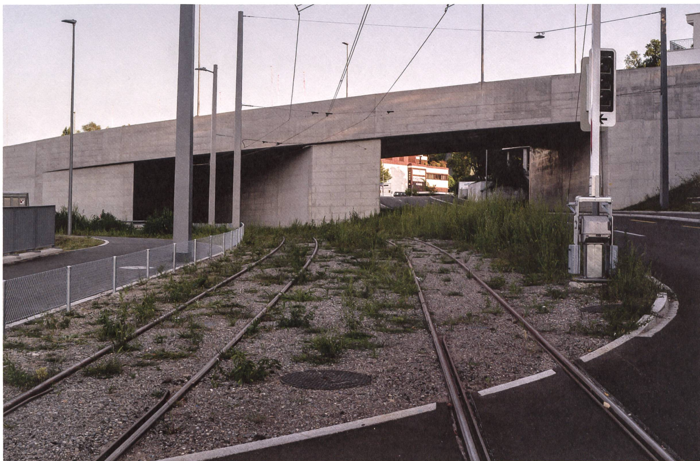
Killwangen: Bei der Überwerfung Zürcherstrasse unterfahren die Limmattalbahn und die Bahnhofstrasse die Zürcherstrasse. →
