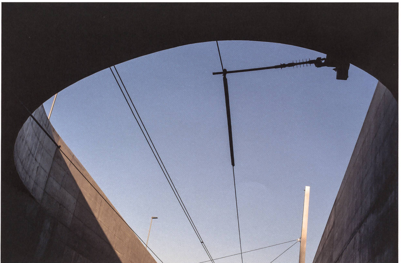
Killwangen: Die Überwerfung Zürcherstrasse zeigt die typischen Gestaltungsmerkmale des Konzepts von 10:8 Architekten. →
