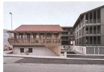
Neu- und Umbau Spalihof, Sachseln OW Seiler Linhart, Luzern
