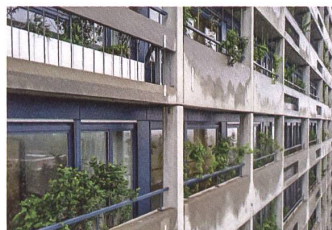
Fassadenbegrünung Hochhaus Stadtsptal Triemli, Zürich Raderschallpartner, Meilen
