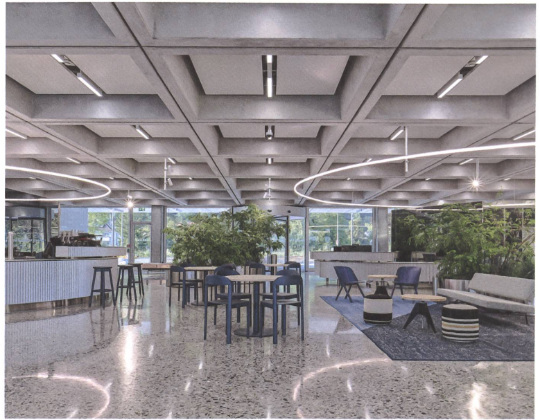
Auch das Erdgeschoss bleibt weitgehend stützenfrei.
