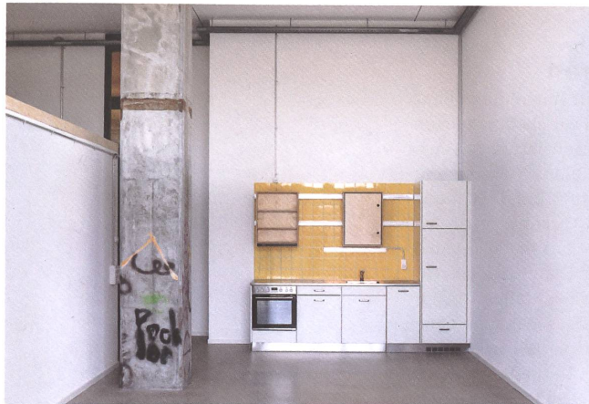
Die alten Lagergeschosse sind luftig, aber nicht hoch genug für reguläre Zwischendecken. Über den als Holzboxen gebauten Räumen können sich die Bewohnerinnen selbst etwas zimmern.
