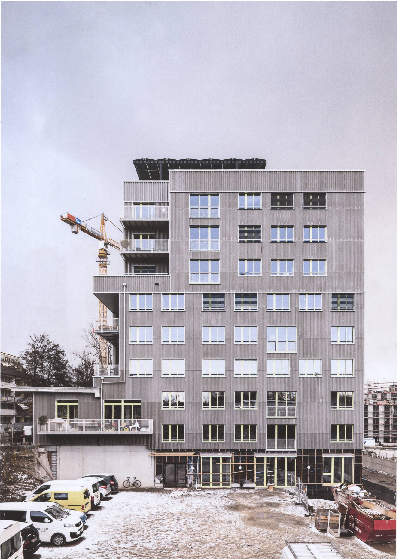
Einheitlich umhüllen Welleternit und giftgelbe Fenster den Bestand und die Aufstockung. Dahinter ein wahres Raumlabirynth, zuoberst Solarpergola und Gemeinschaftsgarten.
