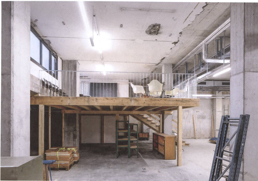
Bis zu vierzig Meter breite und halb im Hang vergrabene Untergeschosse dienen als günstige Gewerbeflächen.
