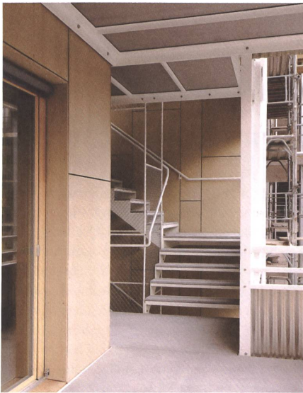
Die Treppe liegt als feine Stahlkonstruktion im Aussenbereich.
