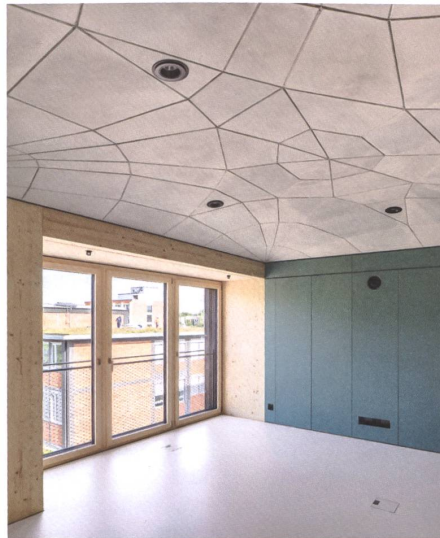
Die Zwischendecke ist in der Mitte leicht gewölbt, passt am Rand aber in jeden Gebäuderaster.
