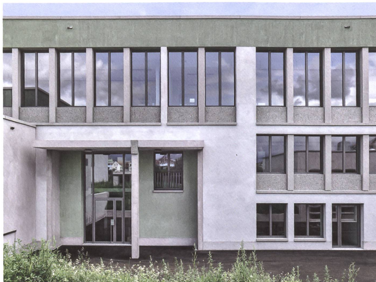
Das Einsteinauerwerk und die Betonelemente der Fassade tragen sich selbst.
