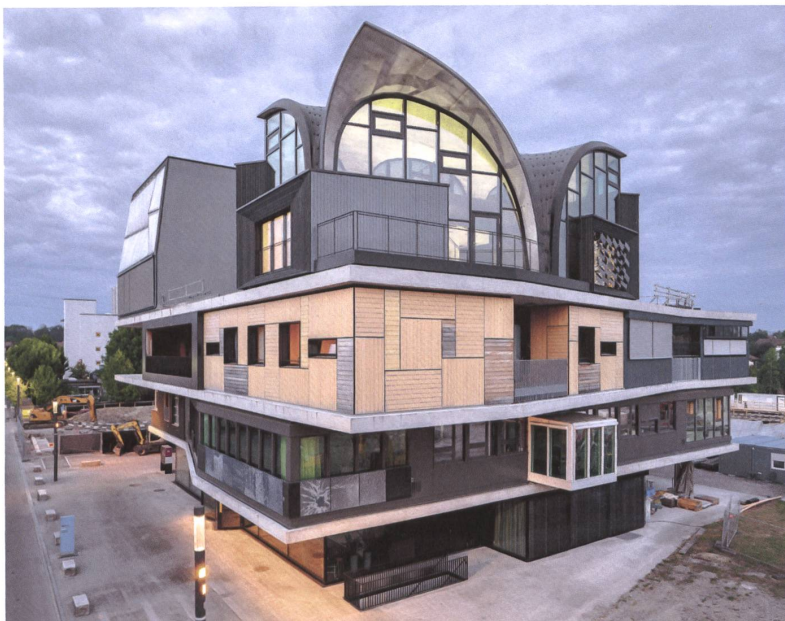
Das HiLo-Modul schwingt auf dem Dach des Nest-Gebäudes in Dübendorf durch die Luft.
