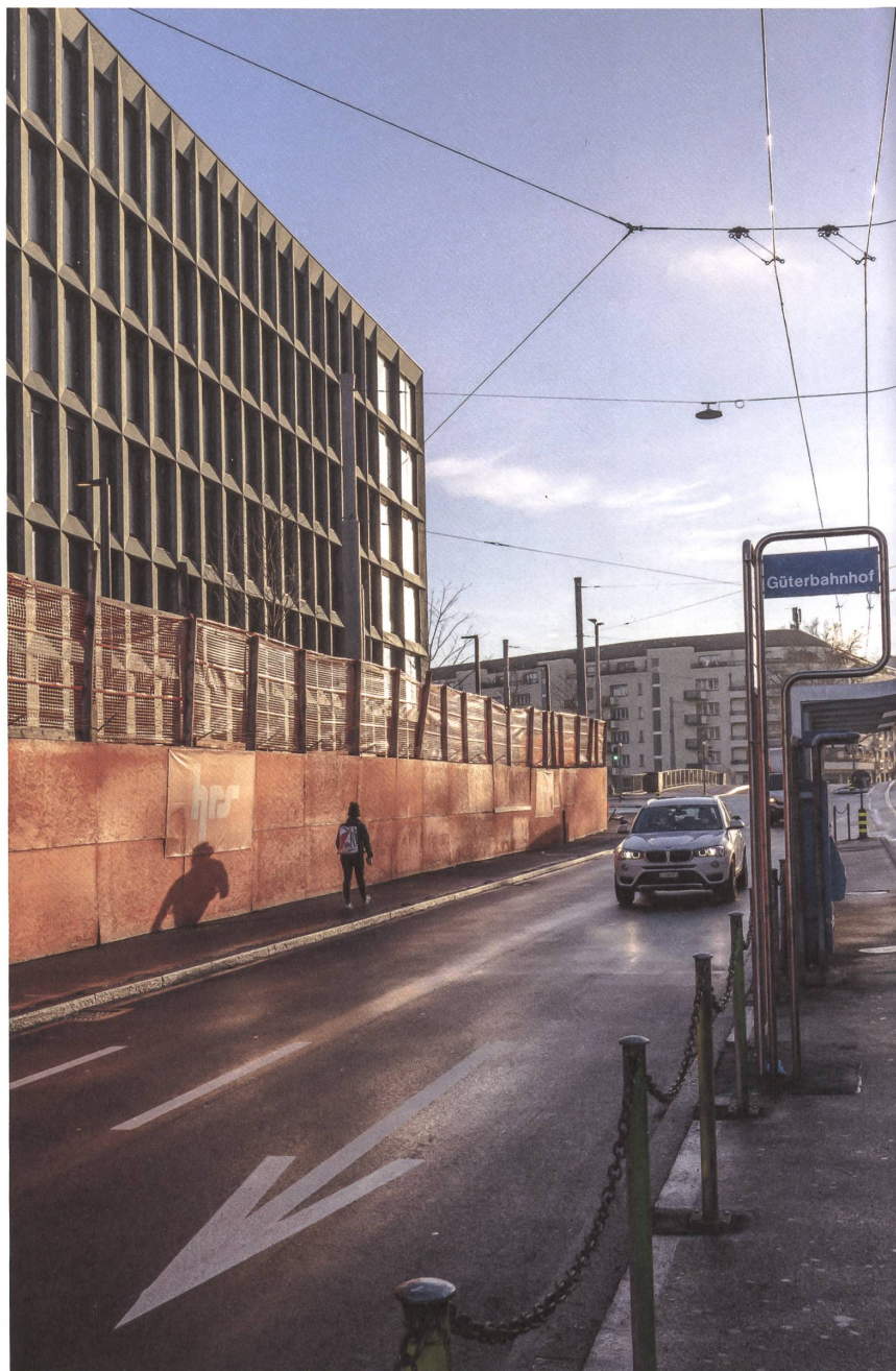
Mächtig steht das PJZ, wo sich der Güterbahnhof befand. Bald kommt eine Kantonsschule dazu.
