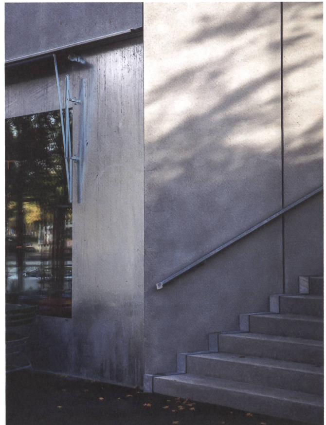
Verzinkte Stahlprofile an den mit Zinkblech verkleideten Ladenfronten.
