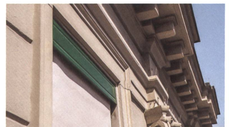
Die Abdeckbleche mit Vertiefung prägen das Fassadenbild mit.
