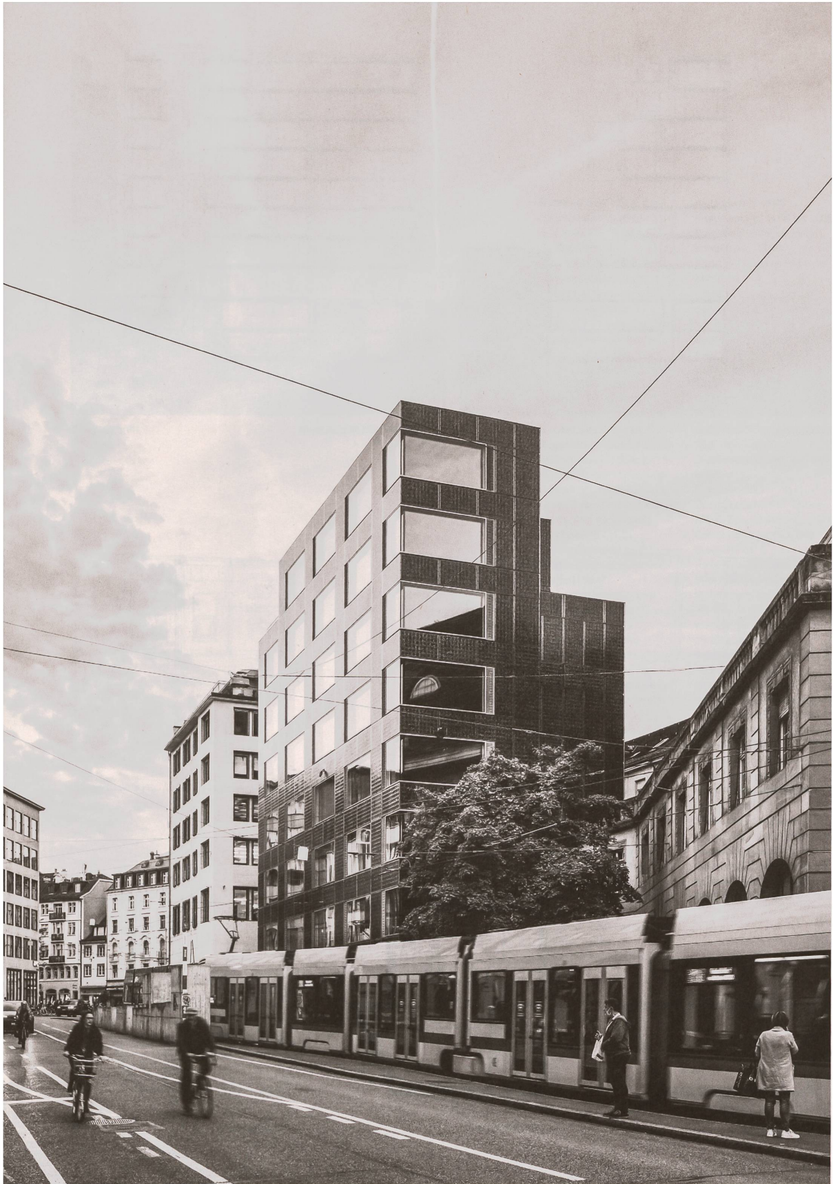
Vom Fischmarkt aus gesehen ist der Neubau des Amts für Umwelt und Energie des Kantons Basel-Stadt schlank und elegant.
