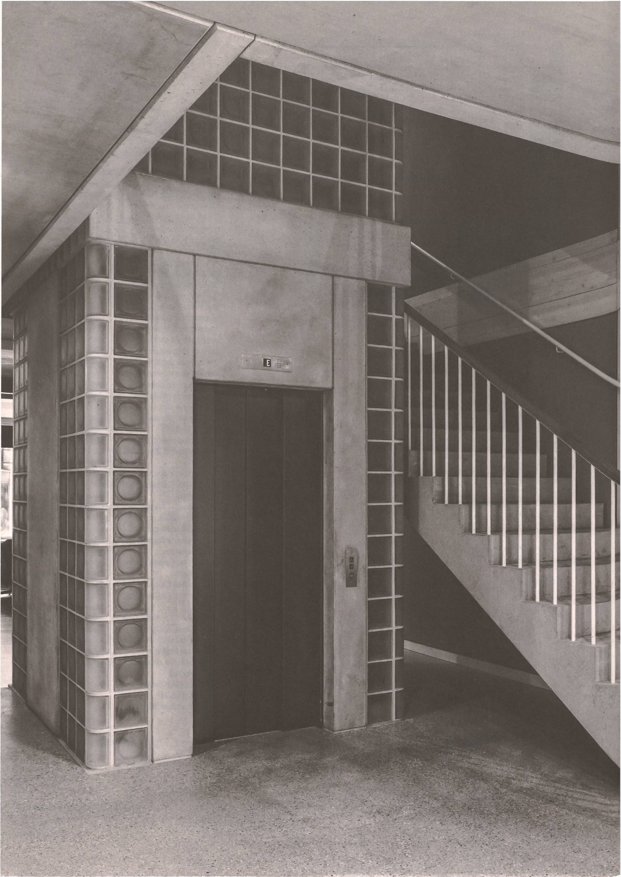
Der Liftschacht im Treppenhaus mit Glasbausteinwänden.
