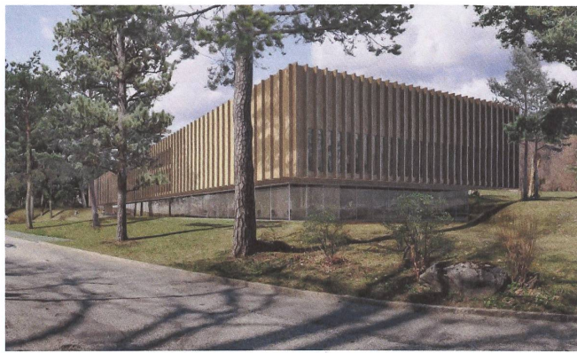
Im Bau: der Ersatz für die Hochschule am Lärchenplatz von Kim Strebel Architekten.
