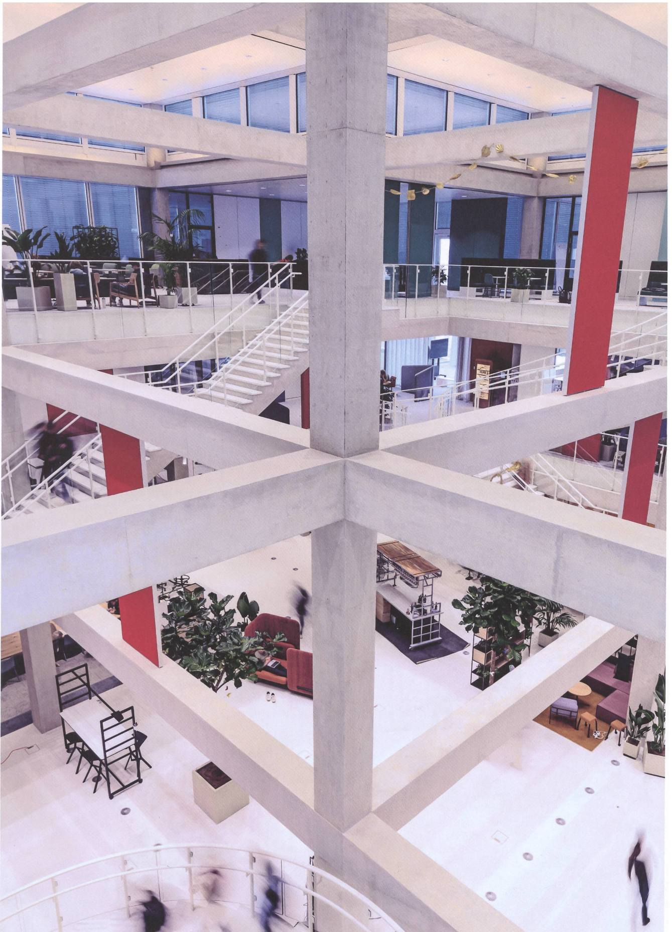
Zehn auf zehn Meter misst das Betonraumgitter im neuen «Lernzentrum» der Universität St. Gallen.
