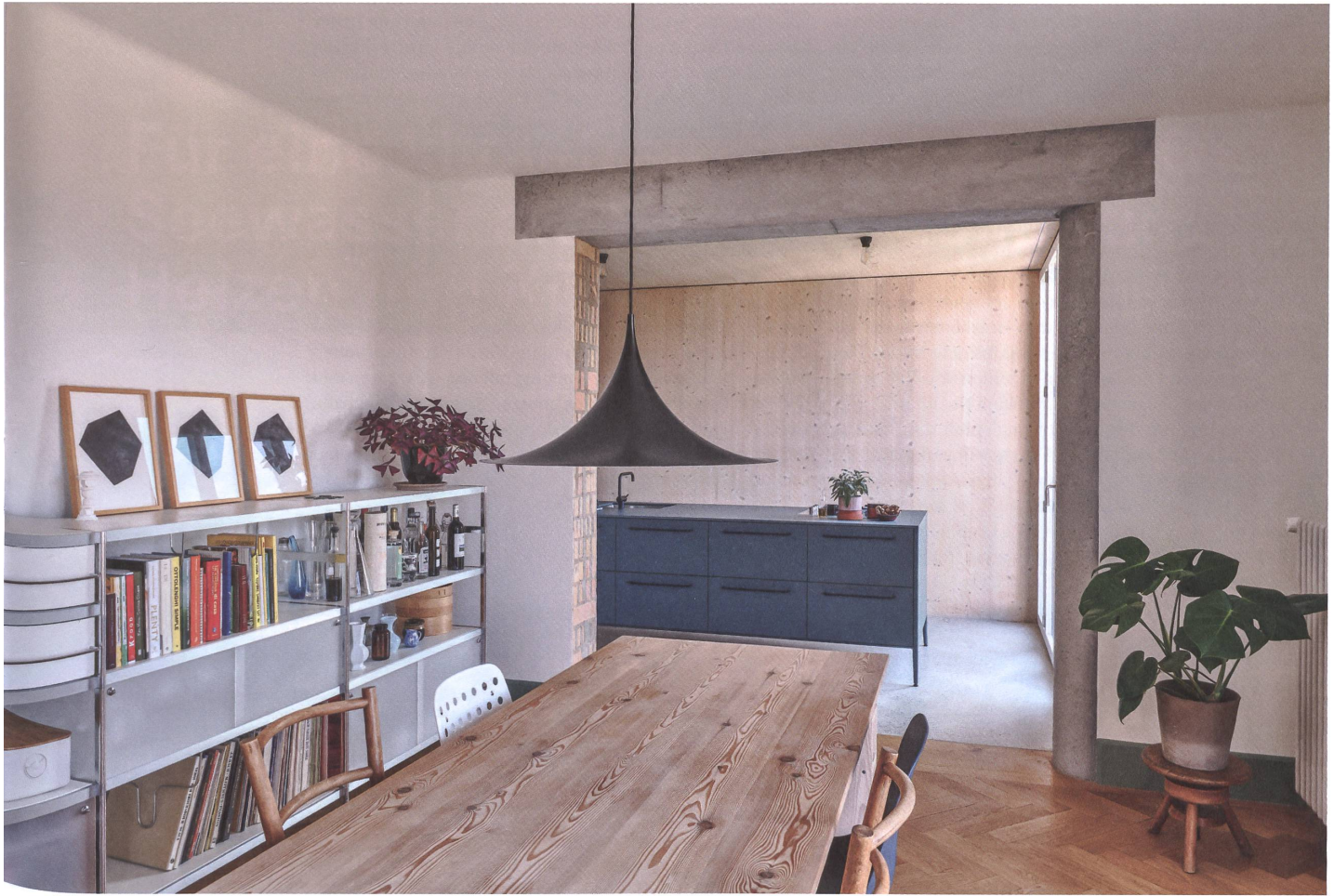
Im Altbau entsteht eine Enfilade, die mit einem sichtbaren Durchbruch in den Zwischenbau führt.
