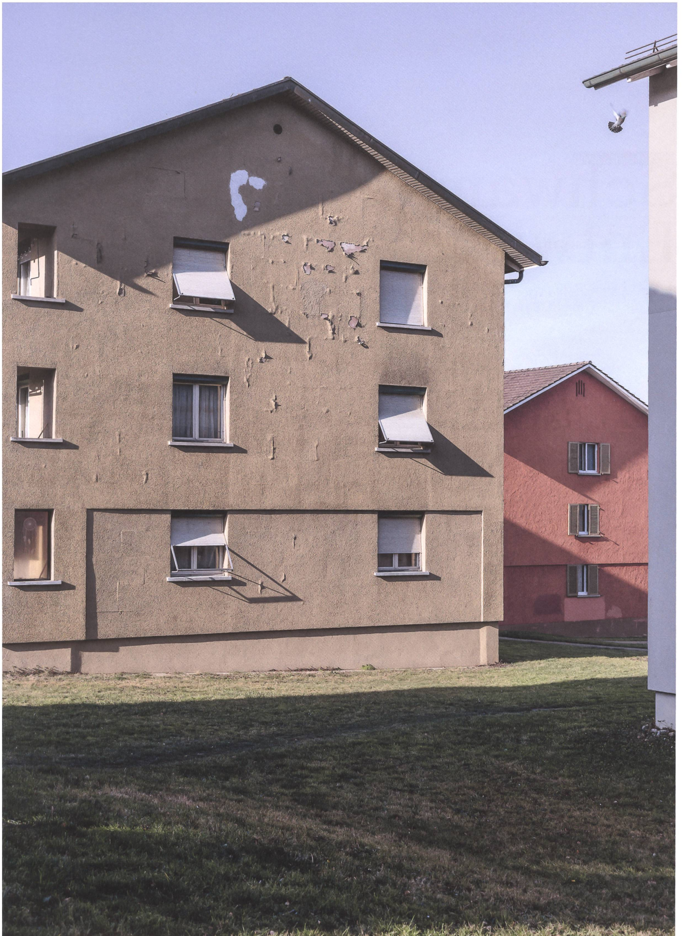
Endzeitstimmung auf dem Areal Altwiesen in Zürich-Schwamendingen: Die Siedlung aus den Fünfzigerjahren wird bald ersetzt.
