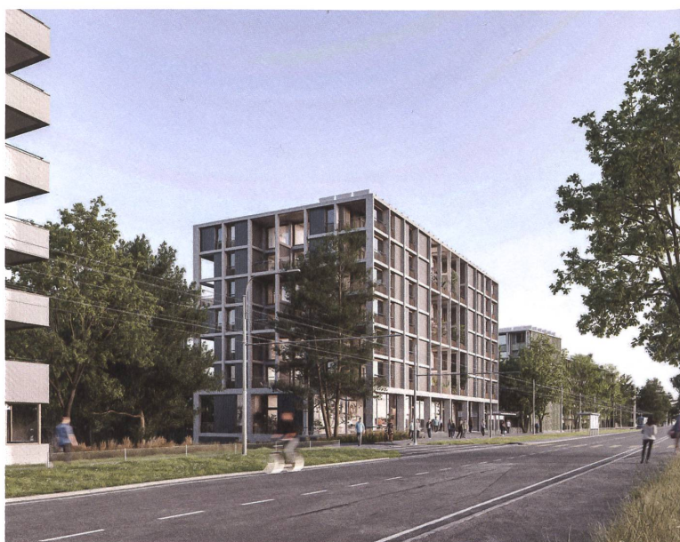
Das Haus 6 ist ein Betonbau mit Photovoltaikfassaden.
