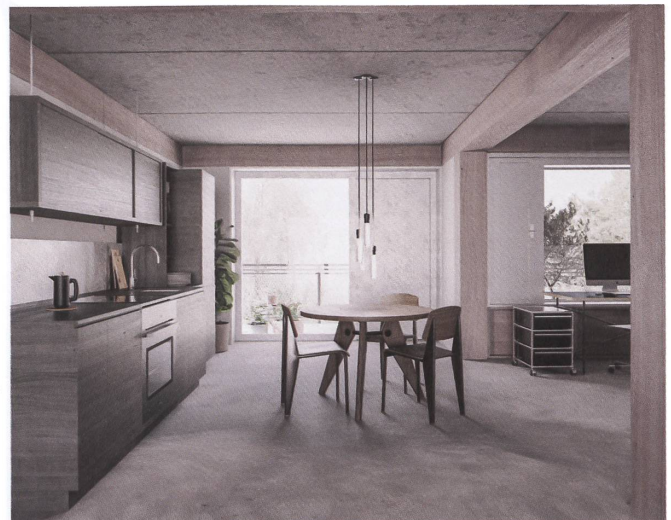
Das Holzskelett trägt Betonverbunddecken.
