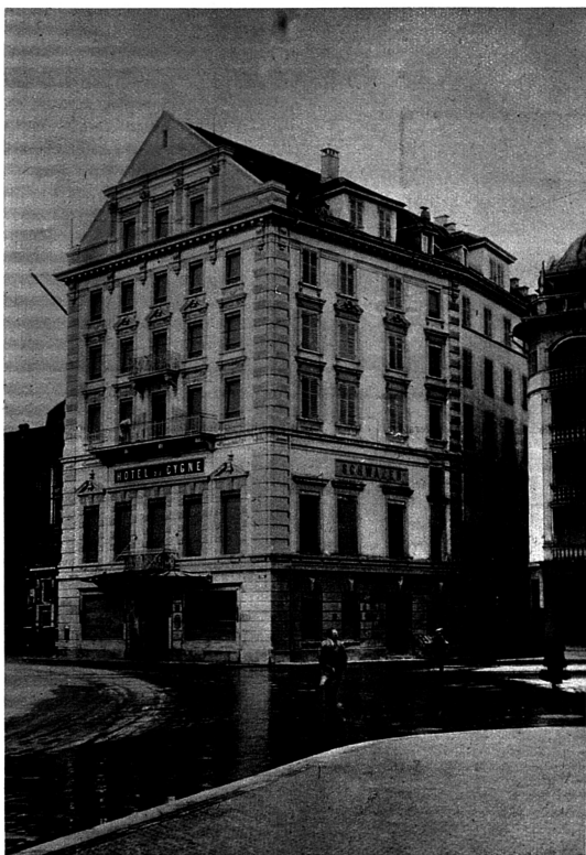
Hotel Schwanen & Rigi, Luzern — Front-Fassade
