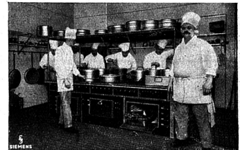
Erste elektrische Hotel-Restaurant-Küche in Deutschland in der „Ewigen Lampe“ in Köln. Einrichtung 1926. Hierzu wurden Schweizer-Herde benutzt.
