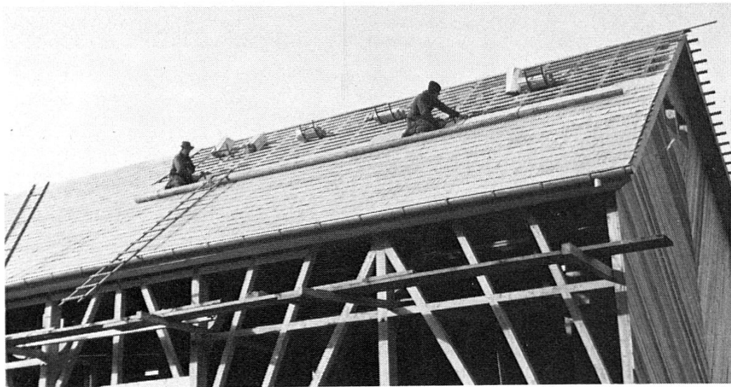
Der Dachdecker legt das Schindeldach
