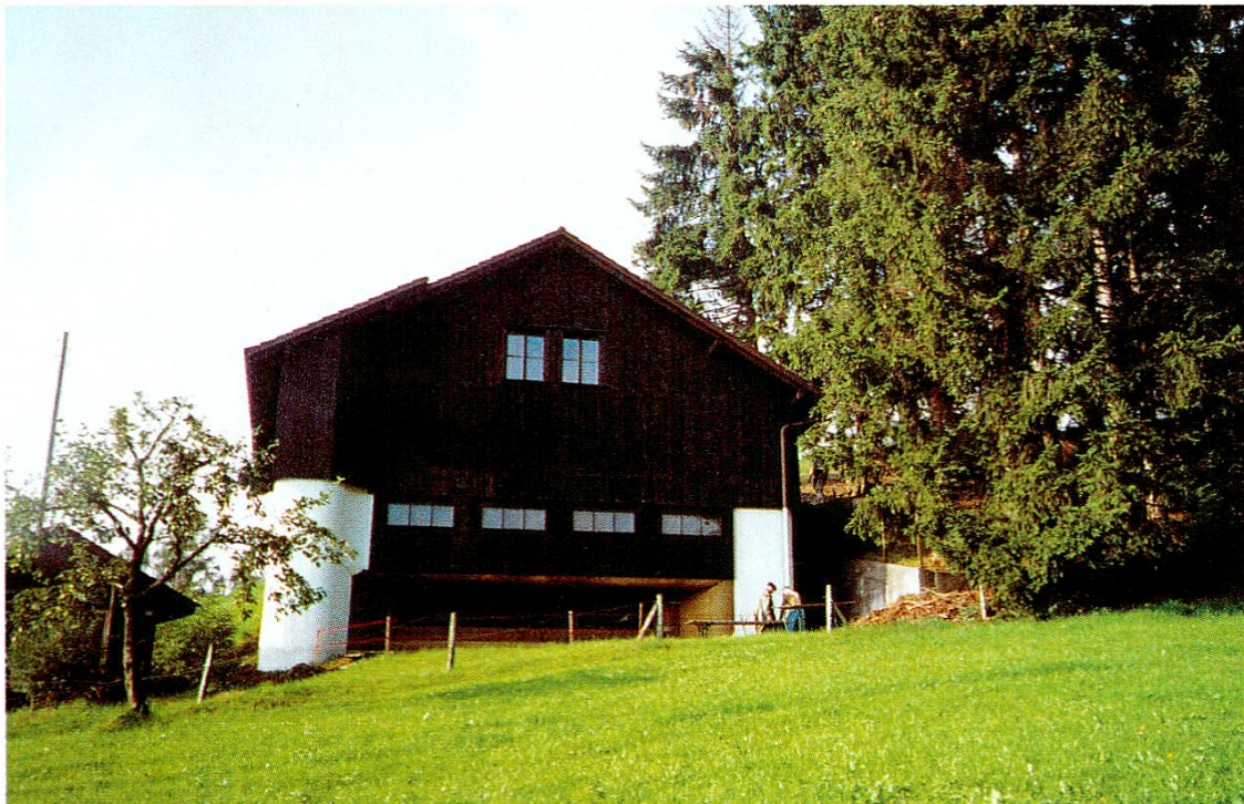
Ein Bunker als Scheune getarnt. Hinter der Fassade verbergen sich über zweieinhalb Meter feste Bunkermauern und Öffnungen für Geschütze.
