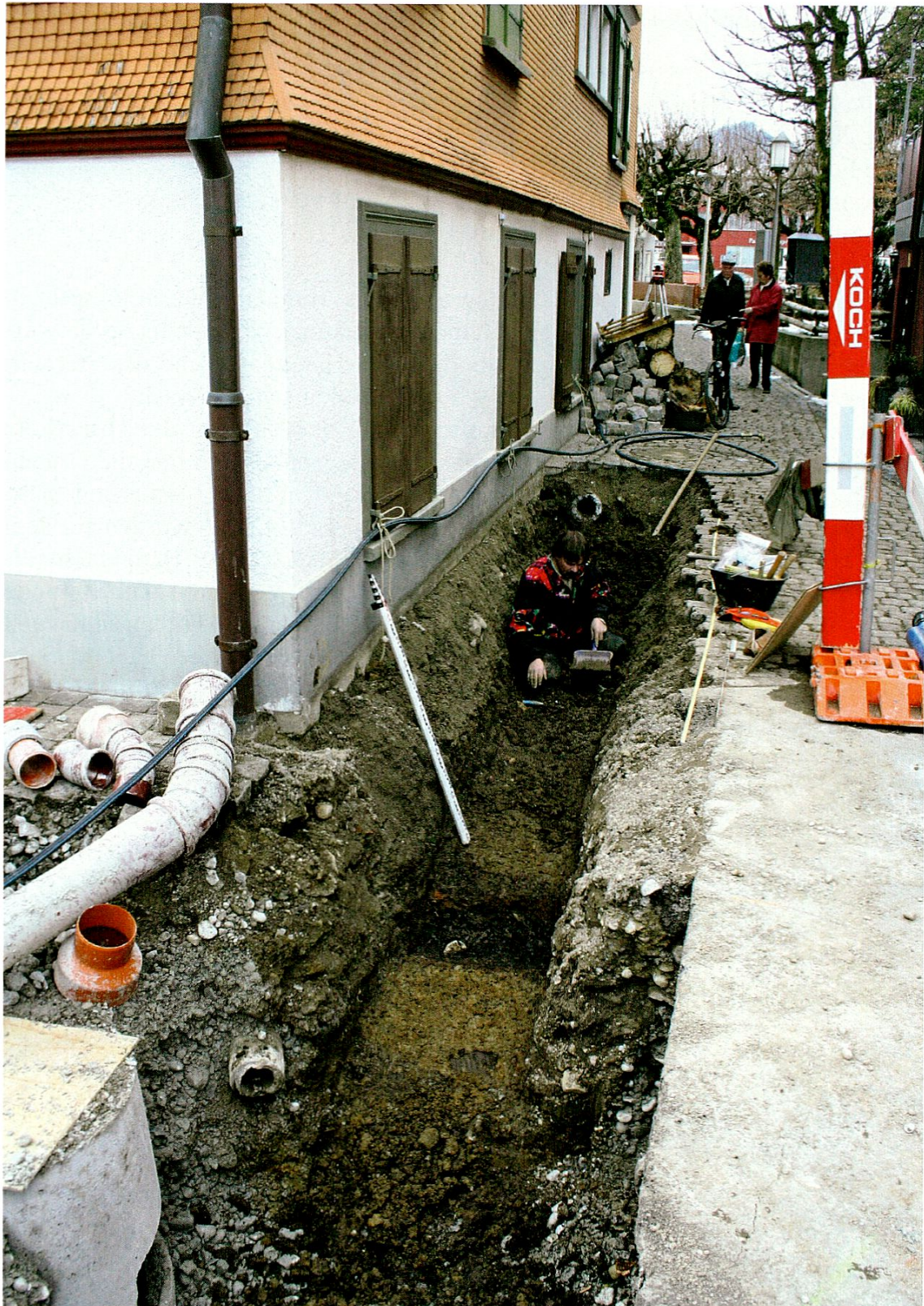
Appenzell, Leitungsgraben auf dem Sternenplatz hinter dem Restaurant «Sternen»: Spuren von Gewerbe oder eines Dorfbrandes? Graben mit rot verziegelten Seitenwänden und aufgefüllt mit Holzkohle. Spätmittelalter/Frühe Neuzeit.
