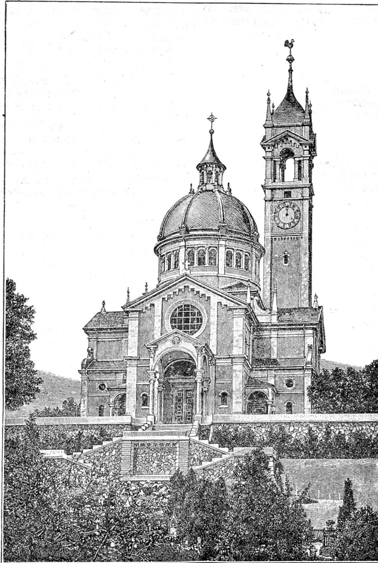
Von Architekt Prof. Bluntschli in Zürich. — Im Rohbau vollendet Mitte Oktober 1893.
