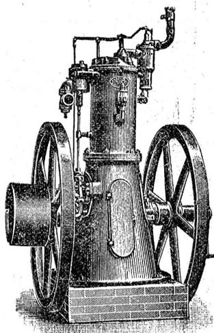
Unbedingt zuverlässiger und ruhiger Gang. Betrieb mit gewöhnlichem Lampenpetroleum oder Benzin. Grösste Dauerhaftigkeit, einfachste Konstruktion. Konsum der Benzin- und Petroleum-Motoren cirka 0,4 bis 0,6 Liter gewöhnliches, billiges Lampenpetroleum oder Benzin pro Pferdekraft und Stunde.
