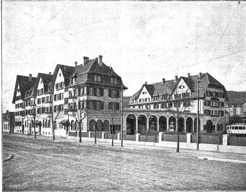
Ansicht des neuen Tramdepot von der Ostseite.
