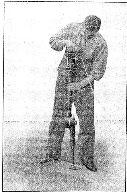
Bild 1. Elektrischer Stampfer für Beton, Zementwaren usw.
