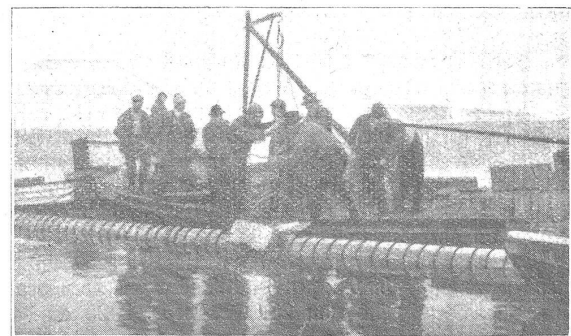
Abb. 15. Auflegen der Betonbelastung (24. Dezember 1924).
