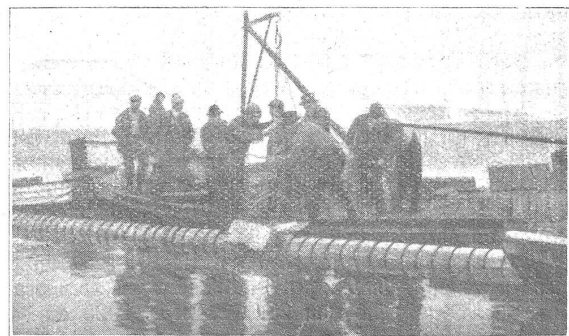
Abb. 15. Auflegen der Betonbelastung (24. Dezember 1924).
