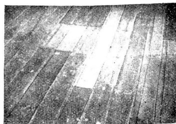
Abb. 14. Reparierter Fußbodenbelag.
