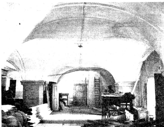
Abbildung Nr. 1. Gewölbte Decke des Erdgeschosses.
