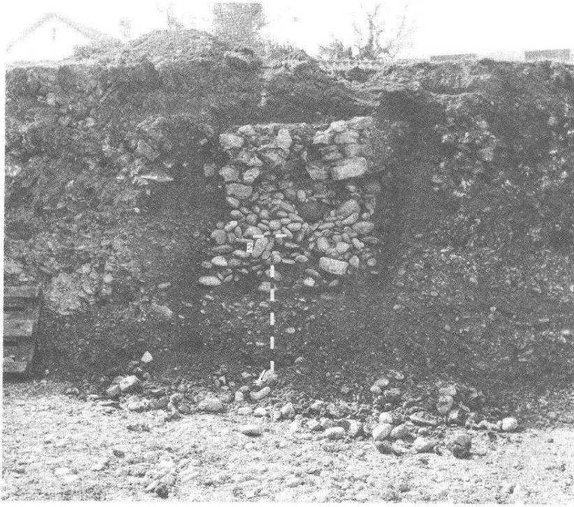
Abb. 13. Augst, Parz. 101, Berger. Mauer im Südprofil der Baugrube mit Fundamentpackung aus Kieselbollen und aufgehendem Mauerwerk mit Kalkbruchsteinen gemauert. Ansicht von Norden.
