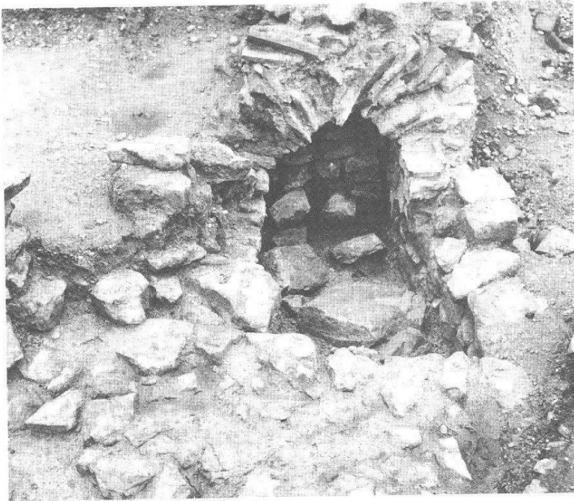
Abb. 5. Augst, Parz. 443/435, Giebenacherstrasse. Kanalöffnung mit Gewölbe, ausgeführt mit Flachziegeln. Im Hintergrund sind Kalkbruchsteine sichtbar, mit denen die Öffnung bei Aufgabe der ursprünglichen Funktion vermauert wurde.
