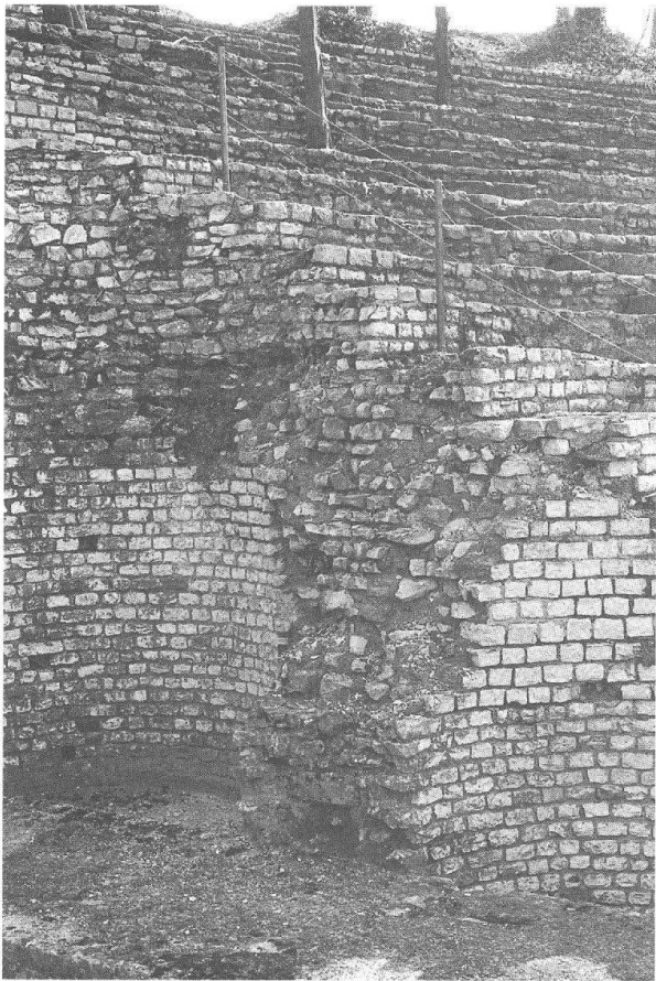
Abb. 5 Augst, Theater: Die alten Restaurierungen, insbesondere auf den Mauerkronen, sind grösstenteils defekt (hier ein Ausschnitt neben dem Mittel-Vomitorium), so dass Regenwasser ins Mauerwerk eindringen kann und durch Frostbildung im Winter zu einer heute akuten Einsturzgefahr geführt hat.
