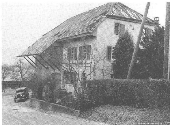
Abb. 1 Süd- und Westfassade des ehemaligen Bauernhofes Frey-Bohny an der Giebenacherstrasse, kurz vor dem Abbruch im Januar 1952. Die Dachziegel sind schon entfernt.
