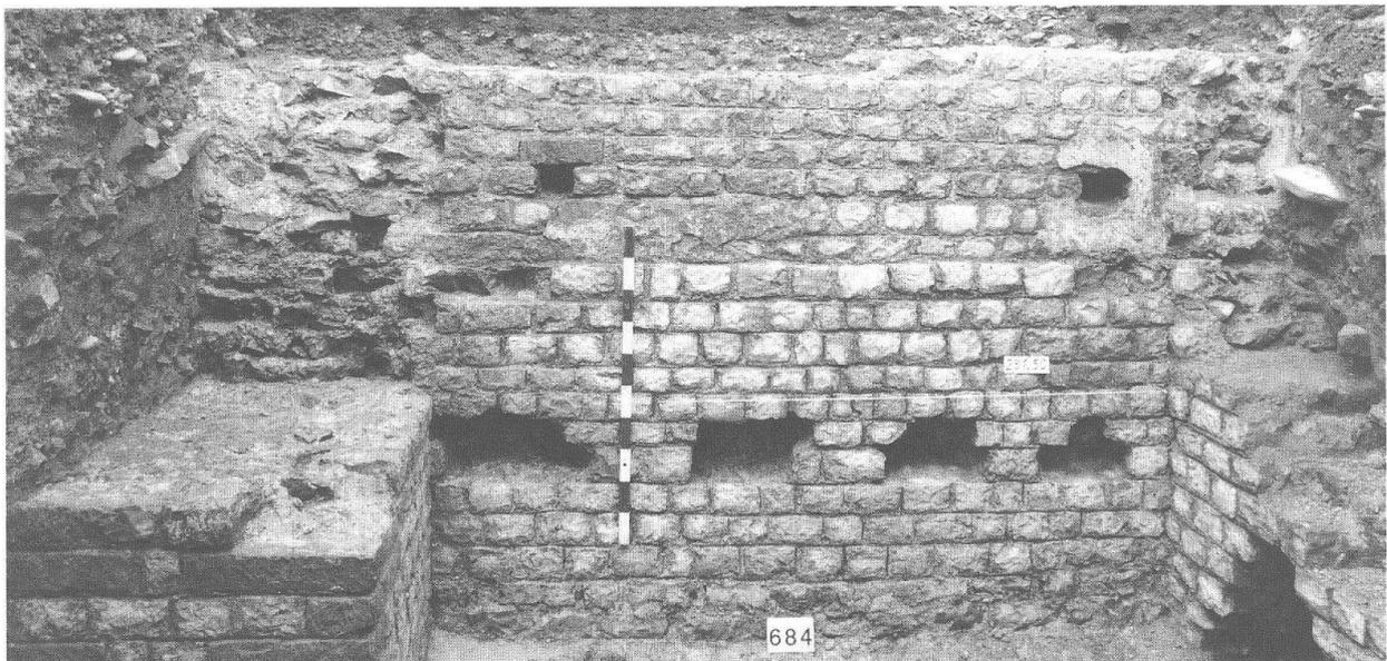
Abb. 53 Augst BL, Grabung 1990.51, Fläche 3. Ansicht der Umfassungsmauer 3 des 1. Theaters in Phase 8. Deutlich zu erkennen sind die beim Abruch der Strebepfeiler 1 und 2 (MR 4 und 9) entstandenen Ausbrüche in der Umfassungsmauer 3, die aus der Bauzeit (Phase 4) stammenden Gerüstbalkenlöcher und die in Phase 6 ausgebrochenen Balkenlager der Kanalabdeckung.
