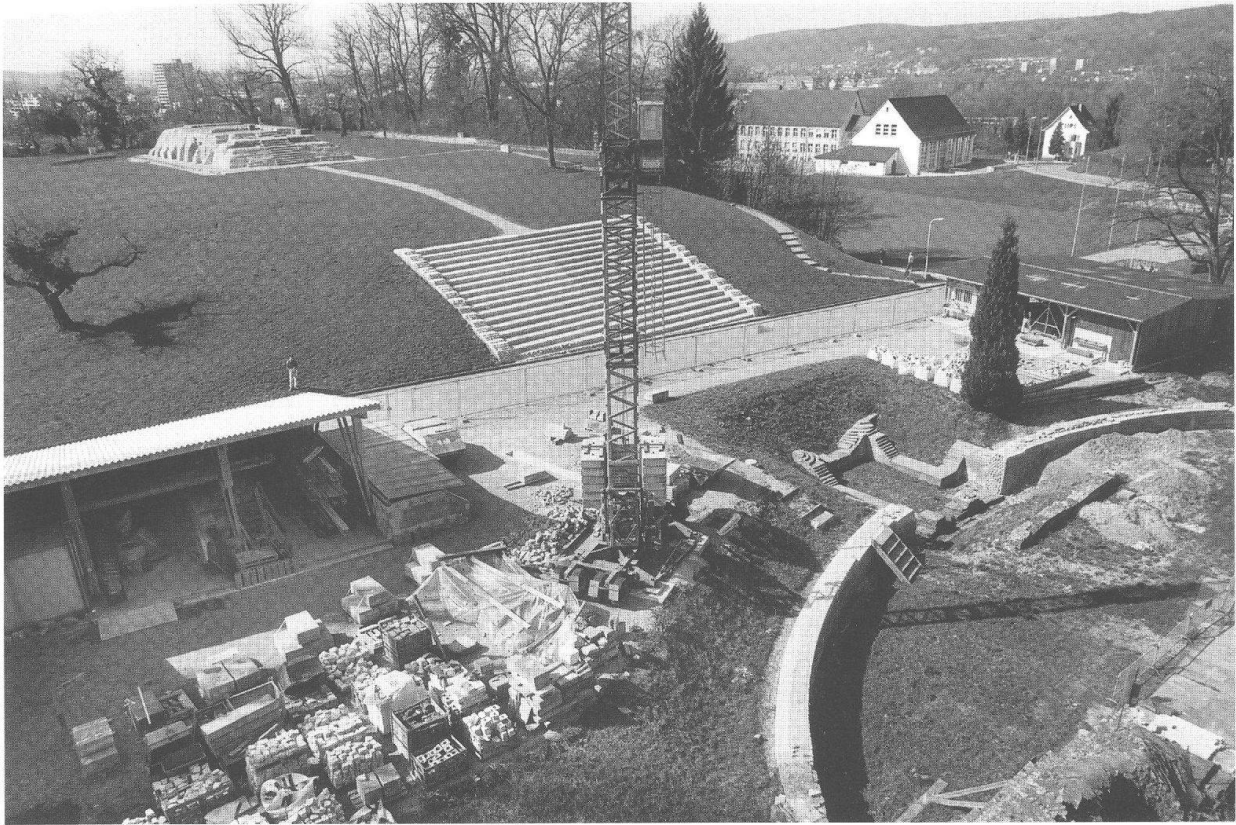
Abb. 18 Augst. Bauhütte und Sanierungsinstallationen vor dem Theater. Hier wurden und werden von 1992 bis ins Jahr 2005 die handwerklichen und dokumentarischen Arbeiten im Rahmen der langwierigen Gesamtanierung des antiken Theaters von Augusta Raurica durchgeführt: Steinhauerarbeiten, Grabungsdokumentation, Mörtelmischen, wissenschaftliche Zeichnungen und Fotos, Materiallagerung usw.
