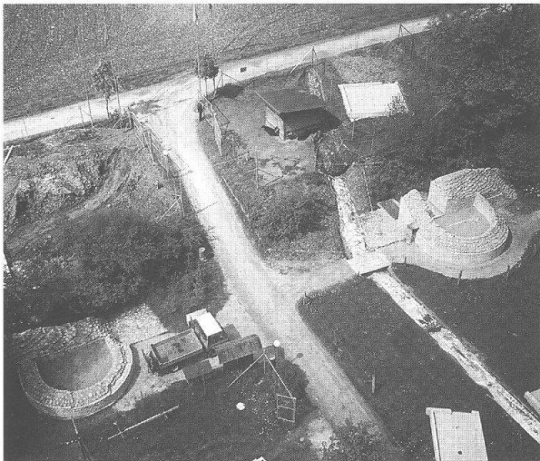
Abb. 34: Augst, Osttorareal (Grabung 1998.56). Das Osttor während der neuen Umgebungsgestaltung. Rechts die ältere Begrenzungsmauer 9 während der Ausgrabung (vgl. Abb. 33); innerhalb der Stadt (oben) hatte man die Mauer 9 noch vor dem Stadtmauerbau teilweise mit Kies überschüttet. Im Stadtvorgelände (unten) blieb die Funktion der Mauer erhalten. Blick gegen Westen.
