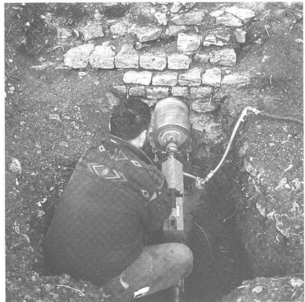
Abb. 16: Augst, Osttorareal (Grabung 1998.56). Kernbohrung von der Aussenseite durch die Stadtmauer (MR 37). Blick gegen Westen. Verlauf der Bohrung s. Abb. 19,8.
