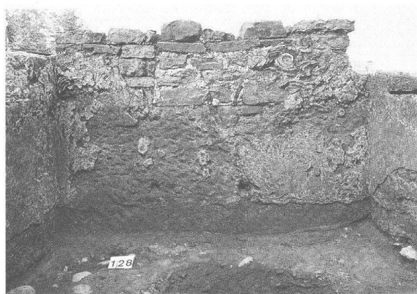
Abb. 8: Kaiseraugst AG, Mehrfamilienhaus Füchter, Allmendgasse (Grabung 1998.03). Blick von Nordosten auf die zugemauerte Wandnische in der Kellermauer West (MR 9).
