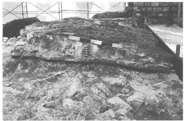
Abb. 39: Augst, Theatersanierung (Grabung 1998.55). Südaditus. Abbau der schadhaften modernen Übermauerung von 1936 auf der inneren Bühnenmauer 43. Die in der Bildmitte quer verlaufende, schwarze Linie ist eine 1936 angebrachte, jetzt unwirksam gewordene Isolationsschicht aus Asphalt gegen Regenwasser.
