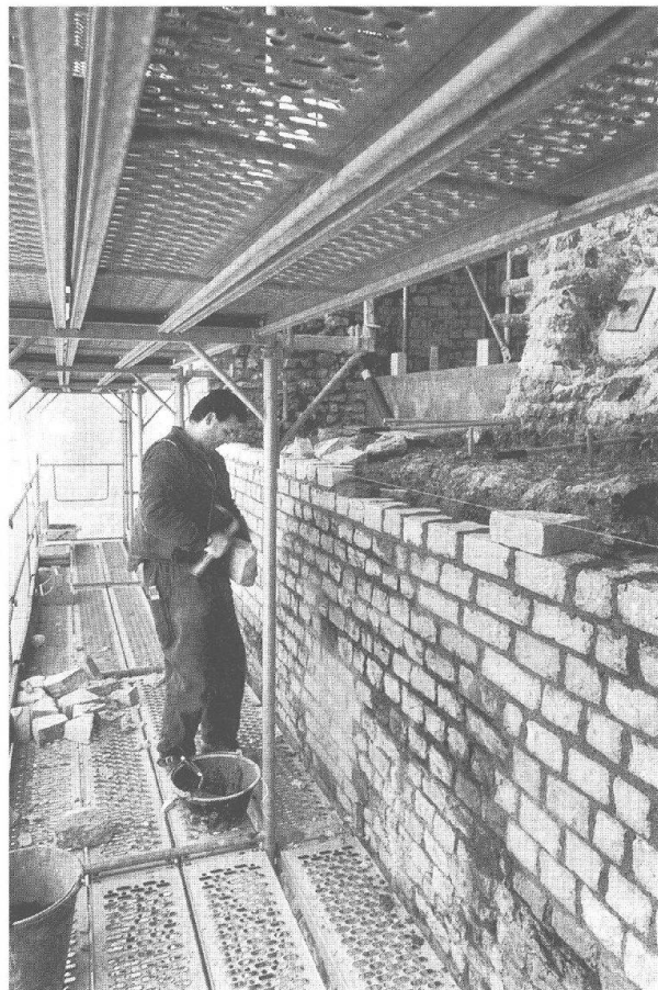
Abb. 19: Augst, Theatersanierung (Grabung 1998.55). Die obere Partie der nördlichen Caveaabschlussmauer (MR 60) während den Aufmauerungsarbeiten.
