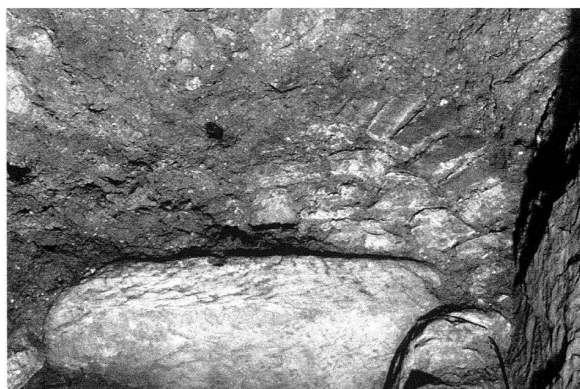
Abb. 27: Augst, Theatersanierung (Grabung 2002.55). Abwasserkanal, Verzweigung im Süden, südöstlicher Abschnitt mit Sandsteinkammer. Blick von Nordwesten an die Südostwand der Sandsteinkammer. Detail des oberen Wandabschlusses mit Sandsteinarchitrav der Mündung des südöstlichen Fortsetzungskanals und darüber liegendem Entlastungsbogen aus Buntsandsteinkeilen (und einem Ziegelkeil).
