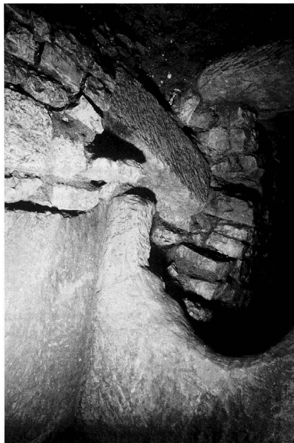
Abb. 29: Augst, Theatersanierung (Grabung 2002.55). Abwasserkanal, Verzweigung im Süden, südöstlicher Abschnitt mit Sandsteinkammer. Blick von Westen in die Sandsteinkammer. Verstärkter Sandsteinarchitrav des von den Frauenthermen her kommenden, nordöstlichen Seitenkanals der jüngeren Phase der Sandsteinkammer.
