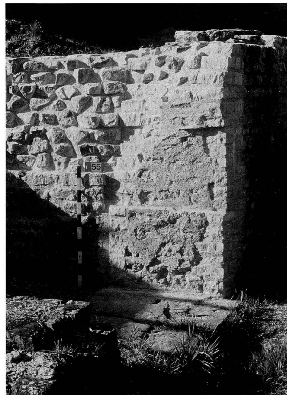
Abb. 43: Augst, Theatersanierung (Grabung 2002.55). Sanierungsarbeiten am Westcarcer des älteren Amphitheaters. Fertig gestellte Anschlüsse der Podiumsmauer an die Nordwestecke des Westcarcers. Wo einst Sandsteinquader als Gewände der Carcerpforten eingebaut waren, finden sich heute, als Folge des antiken und frühneuzeitlichen Steinraubs, nur noch die beim Ausbrechen der Quader entstandenen Raubtrichter. Im Falle des Westcarcers konnte Karl Stehlin in den 1920er Jahren noch die im Kernmauerwerk der Podiumsmauer erkennbaren Negativabdrücke der einst vorhandenen Steinblöcke dokumentieren. Auf der Basis dieser Dokumentation wurden 2002 diese Quadernegative zum besseren Verständnis der baulichen Situation wieder hergestellt.
