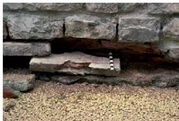
Abb. 15: Augst, Theatersanierung (Grabung 2006.055). Südwanne des Südost-Vomitoriums; die zusammengeklebte Ziegelplatte wird an ihrem ursprünglichen Ort wieder in den Mauerbefund eingefügt.
