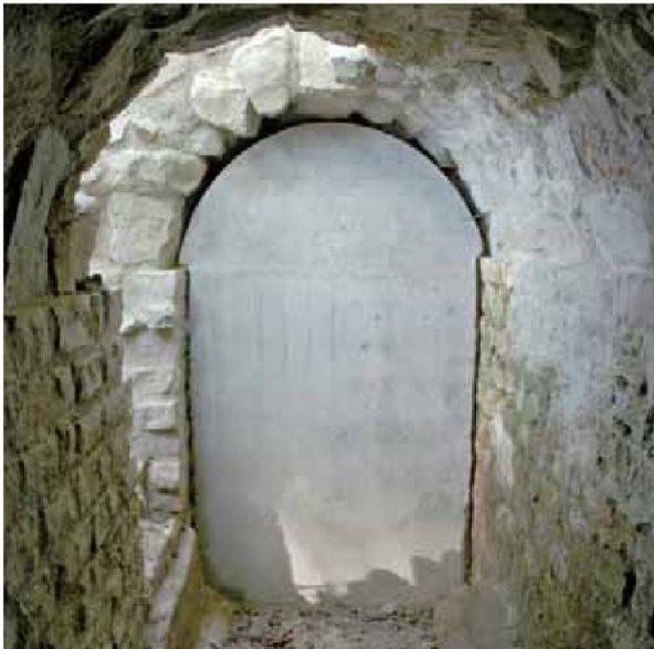
Abb. 47: Füllinsdorf-Wölferhölzli, südliche Peripherie von Augusta Raurica. Restaurierung und Erschließung eines Abschnitts am Ende der 6,5 km langen Wasserleitung Lausen–Augst. Um Vandalismusschäden zu verhindern, wurde die Fortsetzung des unterirdischen Aquädukts mit einer eingepassten, reversiblen Betonscheibe verschlossen. Links der neue Eingang (Abb. 48).
