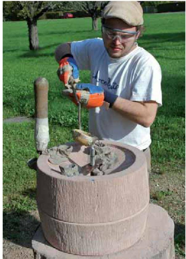
Abb. 7: Zivildienstleistungsatz für einen guten Zweck: Mario Völlmin ist gelernter Steinmetz und hat bei seinem Einsatz in Augusta Raurica u. a. eine römische Steinmühle kopiert. Im Bild vergiesst der Steinmetz in antiker Technik die eiserne Achsführung mit flüssigem Blei im Stein des «Oberläufers» der Handmühle.
