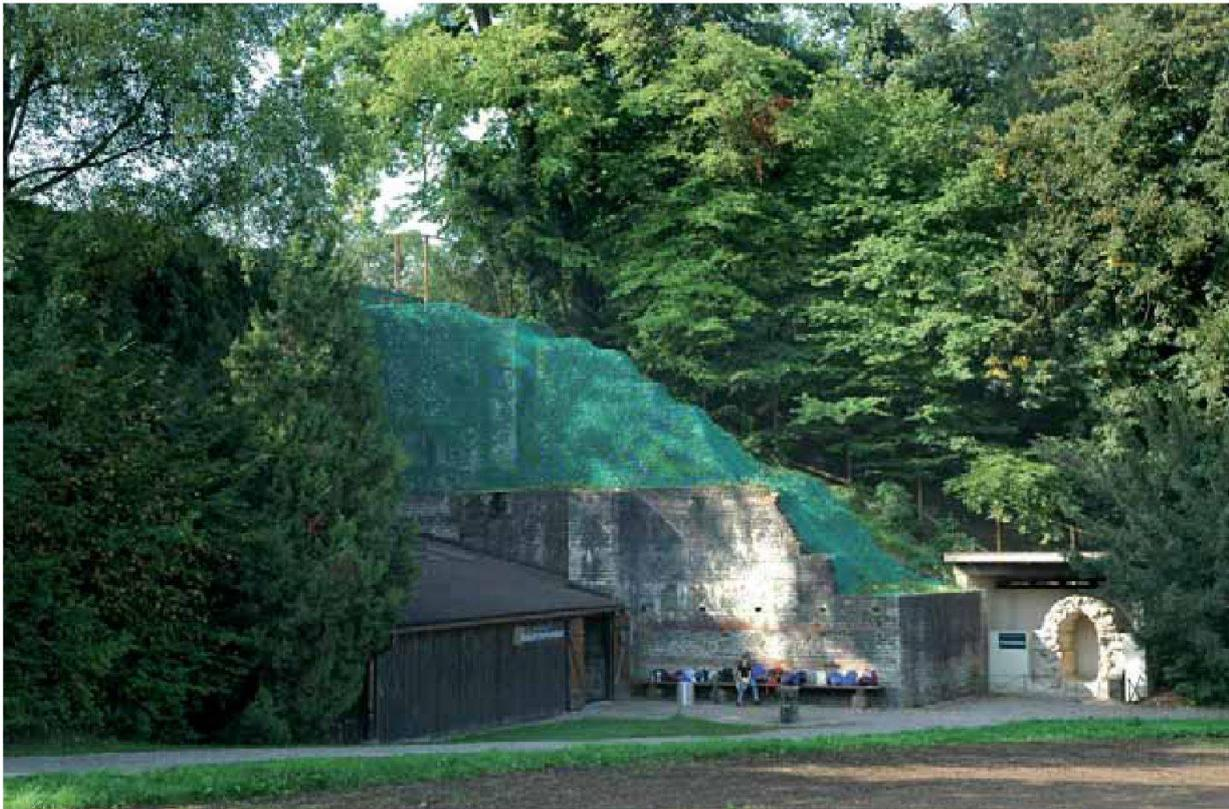
Abb. 52: Augst, Augusta Raurica. Die über 10 m hohe Stützmauer am Fuss des Schönbühl-Tempels ist Anfang des 20. Jahrhunderts restauriert worden. Wegen Einsturzgefahr (s. Abb. 51) mussten Teile davon 2006 provisorisch mit Netzen gesichert werden. Es ist vorgesehen, die Finanzierung zu sichern und diese Gefahrenzone in den nächsten Jahren zu sanieren. Dabei muss auch das Teilstück der römischen Wasserleitung Lausen–Augusta Raurica (rechts) versetzt werden.
