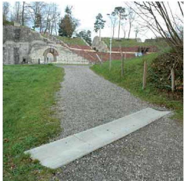
Abb. 62: Augst, Augusta Raurica. Auch der Zugangsweg zur «Römischen Brotbackstube» musste mit einer Regenrinne verbessert werden.
