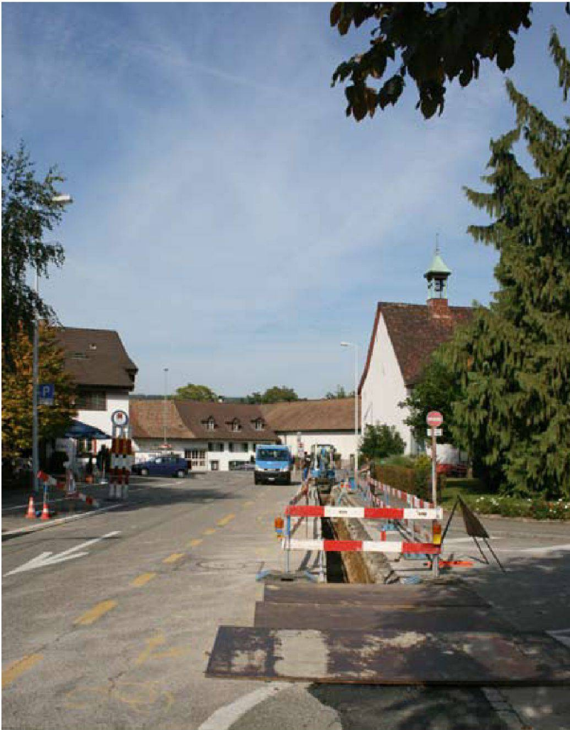
◀ Abb. 52: Augst BL, Poststrasse (Grabung 2010.057). Situation des nördlichen Grabendrittels. Rechts das Gemeindehaus mit dem Dachreiter. Bagger und Lastwagen stehen dort, wo bis 1933 ein Gebäude vorhanden war. Im Hintergrund die Gebäude der Sägerei Ruder, Ort einer weiteren Intervention der Ausgrabungsabteilung Augst, siehe Grabung 2010.056. Von Süden.
