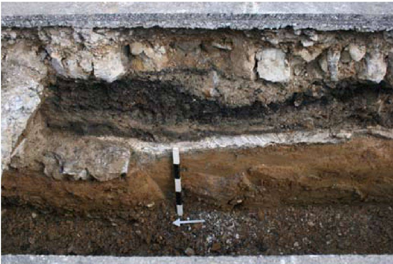
◀ Abb. 56: Augst BL, Poststrasse (Grabung 2010.057). Mauer MR 6 (links Mitte) mit anschließender Sumpfkalkschicht im Ostprofil des Leitungsgrabens. An der Unterkante war die Schicht hart, ansonsten war das weisse Material weich und schmierig. Die darüberliegenden Schichten sind neuzeitlichen Ursprungs und vermutlich sekundäre Verfüllungen der Sumpfkalkgrube. Von Westen.
