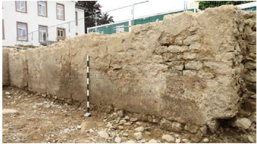
► Abb. 21: Kaiseraugst AG, Autoeinstellhalle Löwen (Grabung 2010.001). Blick von Südosten auf die nördliche Kellerwand MR 30, deren Ziegelschrot-Verputz noch ziemlich gut erhalten war. Stellenweise ist noch der Endverputz aus Kalkmilch sichtbar. Ganz rechts im Bild erkennt man die westliche Aussparung für die Holzschwelle.
