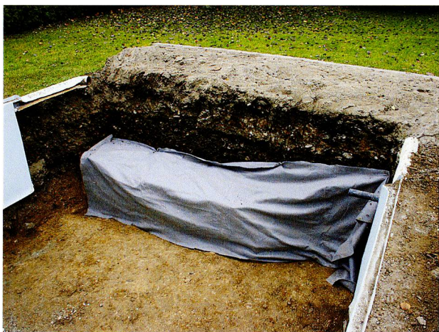
Abb. 43: Augst BL, Insula 20 Schwimmbad (Grabung 2011.066). Mit Vlies verpackte Mauer MR 1; zusätzlich wurden später noch Styroporplatten als Polstermaterial davor gesetzt. Von Norden.
