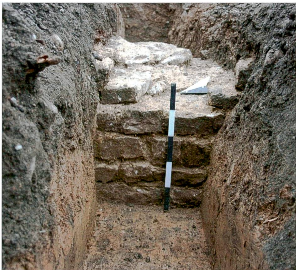
Abb. 10: Augst BL, Tierpark Stadtmauer Ost (Grabung 2013.053). Freigelegtes Teilstück der Ostmauer. Sichtbar ist die Innenseite. Von Westen.
