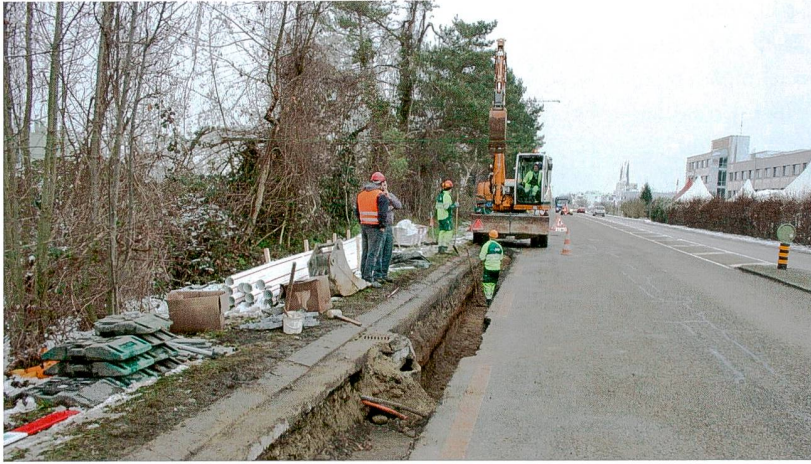
Abb. 3: Augst BL und Pratteln BL, Leitungsgräben (Grabung 2013.051). Aushubüberwachung im westlichen Teil des Leitungsgrabens. Von Westen.
