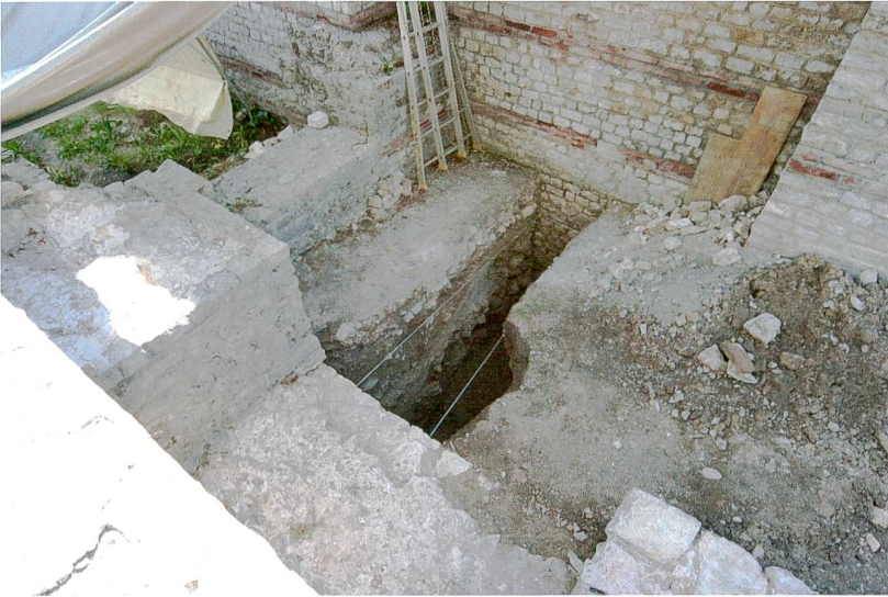
Abb. 24: Augst BL, Stützmauern Basilica (Grabung 2013.057). Sondierung im mittleren Teil des Treppenhauses. Im Hintergrund rechts oben die Basilicastützmauer, vorn im Bild die aussergewöhnlich breite nordwestliche Aussenmauer des Treppenhauses. Von Westen.
