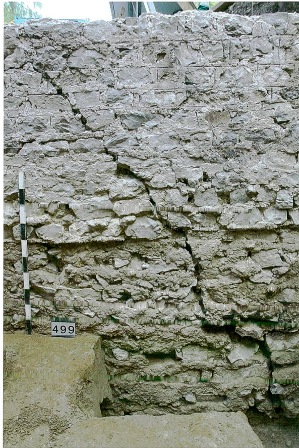
Abb. 22: Kaiseraugst AG, Umbau Dorfstrasse 29 (Grabung 2014.008). Ansicht von MR 10 mit gemörteltem Fundament. Das obere Mauerwerk wurde sorgfältig mit Fugenstrich ausgeführt. Blick von Norden. Schnurhöhe: 266,40 m ü. M.
