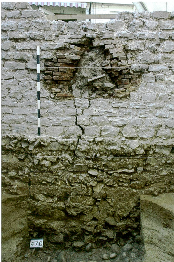
Abb. 40: Kaiseraugst AG, Umbau Dorfstrasse 29 (Grabung 2014.008). Blick von Norden auf das Nordhaupt von MR 19 und der spätantiken MR 2 mit dem Praefurnium MR 14. Der unterschiedliche Baucharakter der beiden Mauern ist auf den ersten Blick ersichtlich. Das massive, gemörtelte Fundament von MR 19 reicht bis auf den anstehenden Rheinschotter hinunter. Ein Riss setzt im Fundamentbereich von MR 19 an und reicht bis zum Praefurnium MR 14. Schnurhöhen: 265,60 und 266,60 m ü. M.
