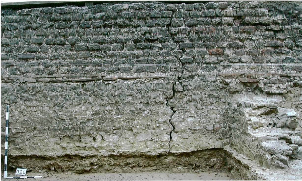
Abb. 39: Kaiseraugst AG, Umbau Dorfstrasse 29 (Grabung 2014.008). Blick von Osten auf das Osthaupt von MR 1/MR 21. Die beiden Mauern werden hier durch ein ein- bis zweilagiges Ziegelband als Ausgleichslage für die spätantike MR 1 getrennt. Durch beide Mauern verläuft ein ausgeprägter Riss, der auf statische Probleme hinweist. Unten rechts MR 33, die mit MR 21 im Verband steht. Schnurhöhe 267,10 m ü. M.
