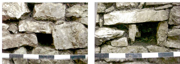
Abb. 7: Kaiseraugst AG, Auf der Wacht (Grabung 2011–2013.001). Schacht MR 6/MR 32 (Zustand im März 2016). Mit modernen Holzbalken markierte Balkennegative in MR 6 und Detailaufnahmen der beiden Balkennegative (vgl. dazu auch Abb. 9).
