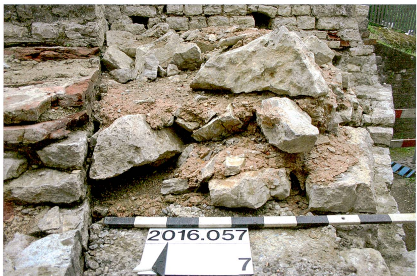
Abb. 56: Augst BL, Stützmauern Basilica (Intervention 2016.057). Nordwestliche Kanalwanne MR 28 der Kloake. Auf der Kämpferlinie (rechts im Bild) liegen einige leicht abgeschrägte Kalksteine des Widerlagers zum Bogen. Darüber finden sich grössere, stärker abgeschrägte Kalksteine, die als Widerlager für einen zweiten Bogen dienten. Blick von Süden.
