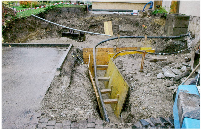
Abb. 90: Augst BL, Steinlerstrasse 7 (Baubegleitung 2016.069). Blick von Osten auf die Baugrube von 2016.
