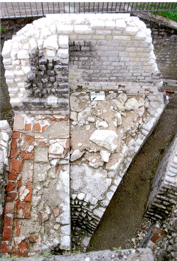
Abb. 54: Augst BL, Stützmauern Basilica (Intervention 2016.057). Feld 16 mit den beiden dokumentierten Mauern MR 5 (links im Bild) und Kanalwange MR 25 (Bildmitte). Blick von Südosten.
