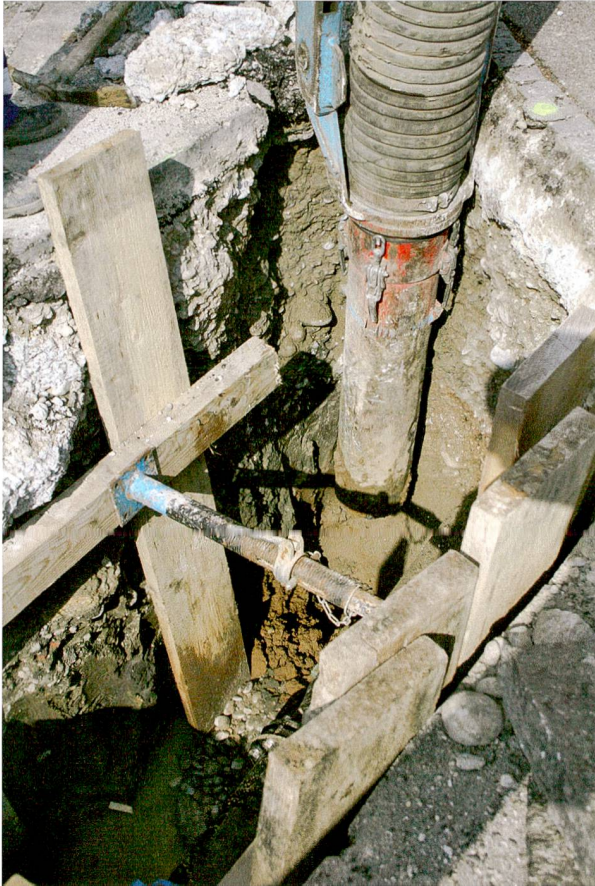
Abb. 88: Pratteln BL, Augsterstrasse (Baubegleitung 2016.068). Auf der Kreuzung von Augster-, Heissgländ- und Wyhlenstrasse zeichnen sich die einzigen Befunde im sonst sterilen Rheinschotter ab: Eine dunkelbraune, kompakte Schicht mit gebrannten Tonbröckchen verläuft von links unten diagonal durch das Bild. In der Bildmitte unter dem Rohr des Saugbaggers ein rotbraunes, sandig-lehmiges Sediment. Datierung und Funktion sind unbekannt.
