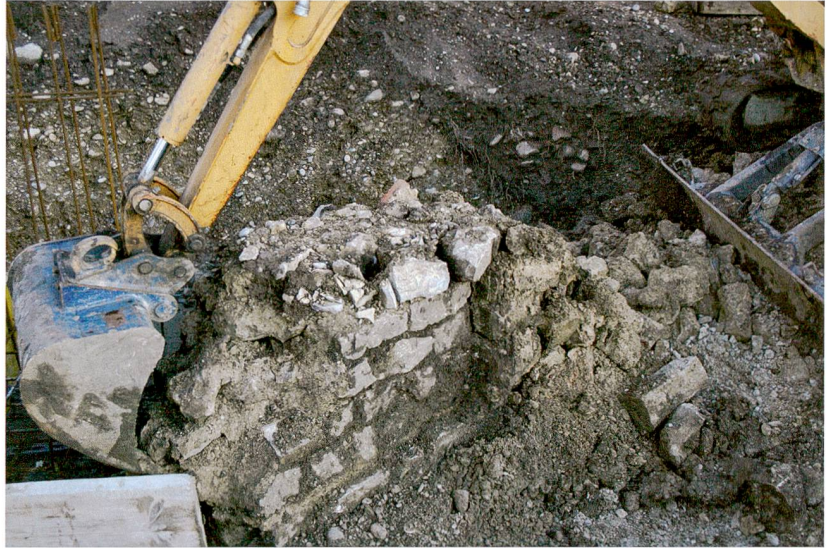
Abb. 83: Augst BL, EFH Sichelstrasse (Grabung 2016.065). Der Eckbereich MR 1/MR 3 wird mit dem Bagger zerstört. Blick von Westen.
