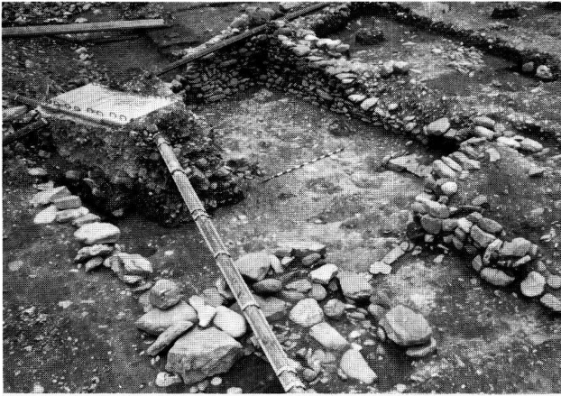
Abb. 1. Schiers GR, Chrea. 1986: Spätrömisch-frühmittelalterliches Grubenhaus mit Eingangspartie; jüngere Bauphase (links im Bild: Telefonkabelkasten). Photo AD GR.
