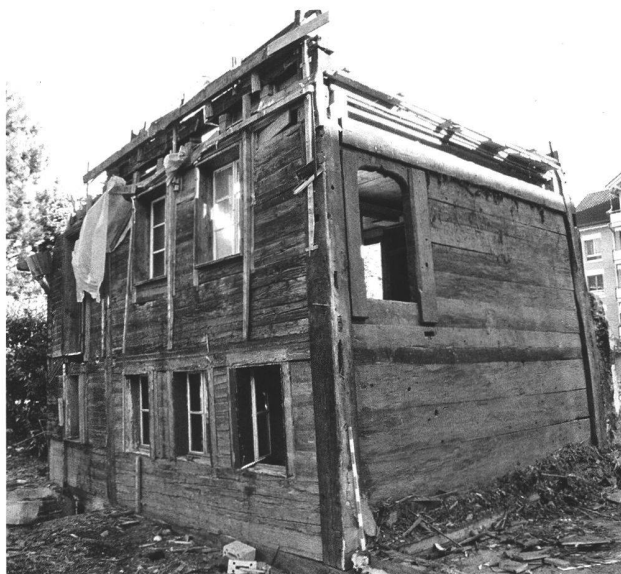
Abb. 22. Baar ZG, Leihgasse 39/41. Der Bohlenständerbau von 1419/20 nach dem Abbruch des Bauernhauses von 1664 und kurz vor dem Abbau und Abtransport der Bauteile. Foto KA ZG, M. Bolli.
