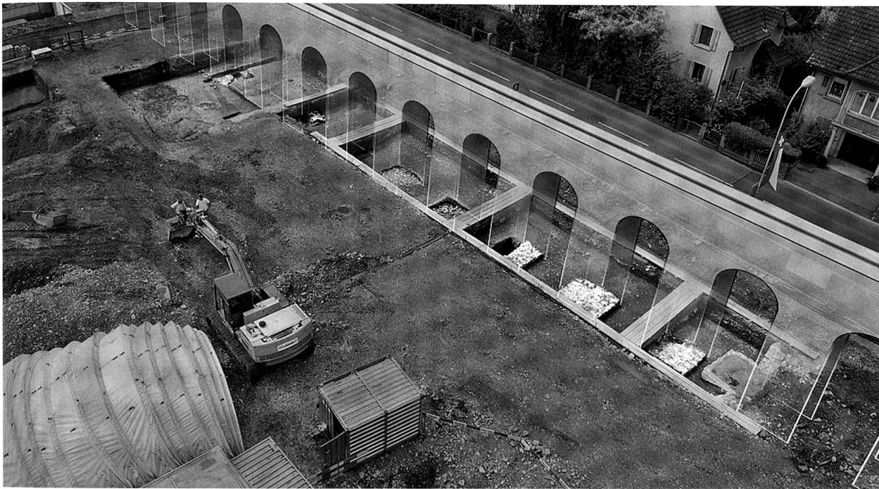
Abb. 32. Windisch AG, Dorfzentrum (V.011.1). Über den zehn Aquaedukt Pfeilerfundamenten ist als schematische Rekonstruktion die 9 m hohe Aquaeduktbrücke eingetragen. Blick aus Nordosten. Illustration KA AG, M. Zinggeler/M. Fricker (Foto) und M. Flück (Rekonstruktion).
