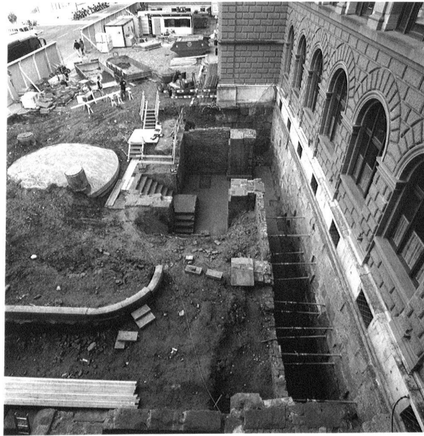
Abb. 54. Bern BE, Bundeshaus Ost. Blick in den Gewölbekeller des barockzeitlichen Spitals. Foto ADB.
