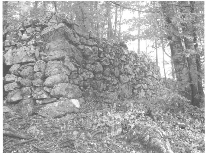
Abb. 21. Meiringen-Wyghus (Abb. 2,7). Blick an den Eckverband zwischen der Südmauer (links) und Ostmauer rechts des «Schänzli Nydegg». Foto P.-A. Schwarz.
