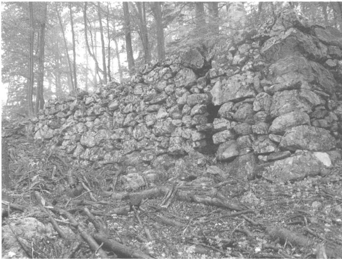
Abb. 20. Meiringen-Wyghus (Abb. 2,7). Blick an die aus grossen Kalkbruchsteinen errichtete Südmauer des «Schänzli Nydegg». Foto P.-A. Schwarz.
