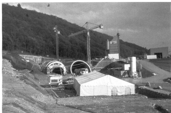
Fig. 2. Concise VD-Les Courbes Pièces. Vue vers l'est du chantier de construction des tunnels de Concise. Photographie Archeodunum SA.
